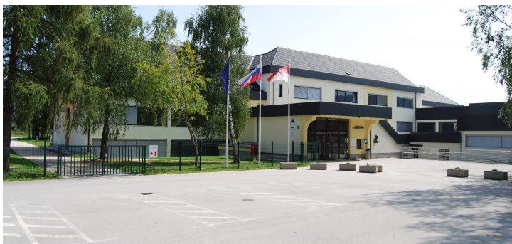
Slika 3: Pročelje OŠ F.S. Finžgarja Lesce
